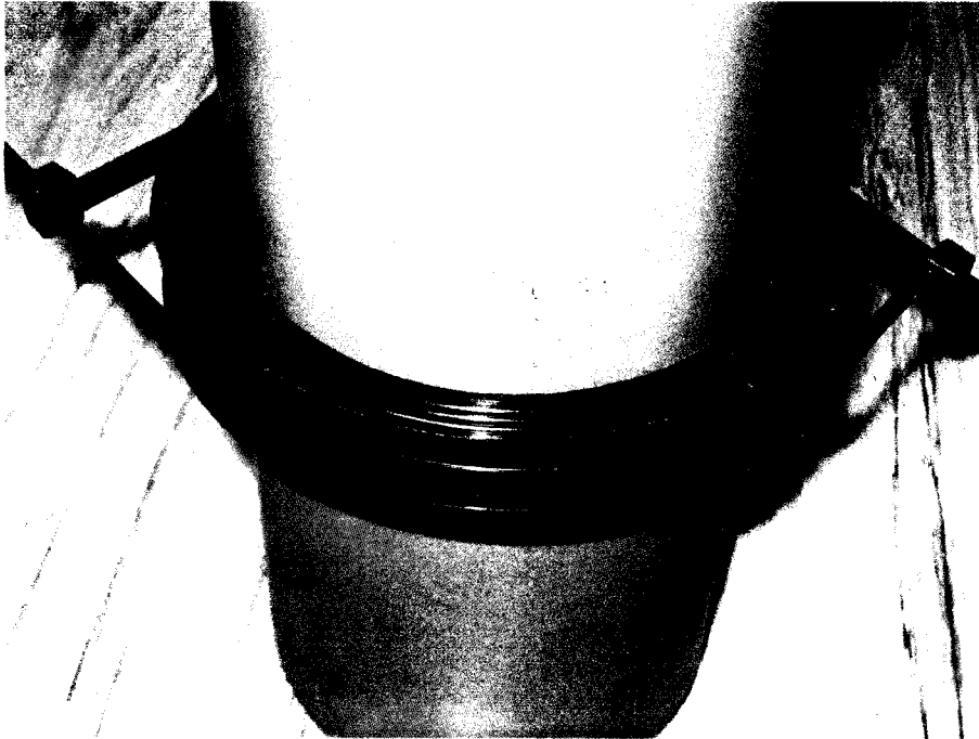
Bild 1: DOC System Rohrkragen , montiert auf einem KG 2000-Rohr, vor dem Anziehen der Kabelbinder
